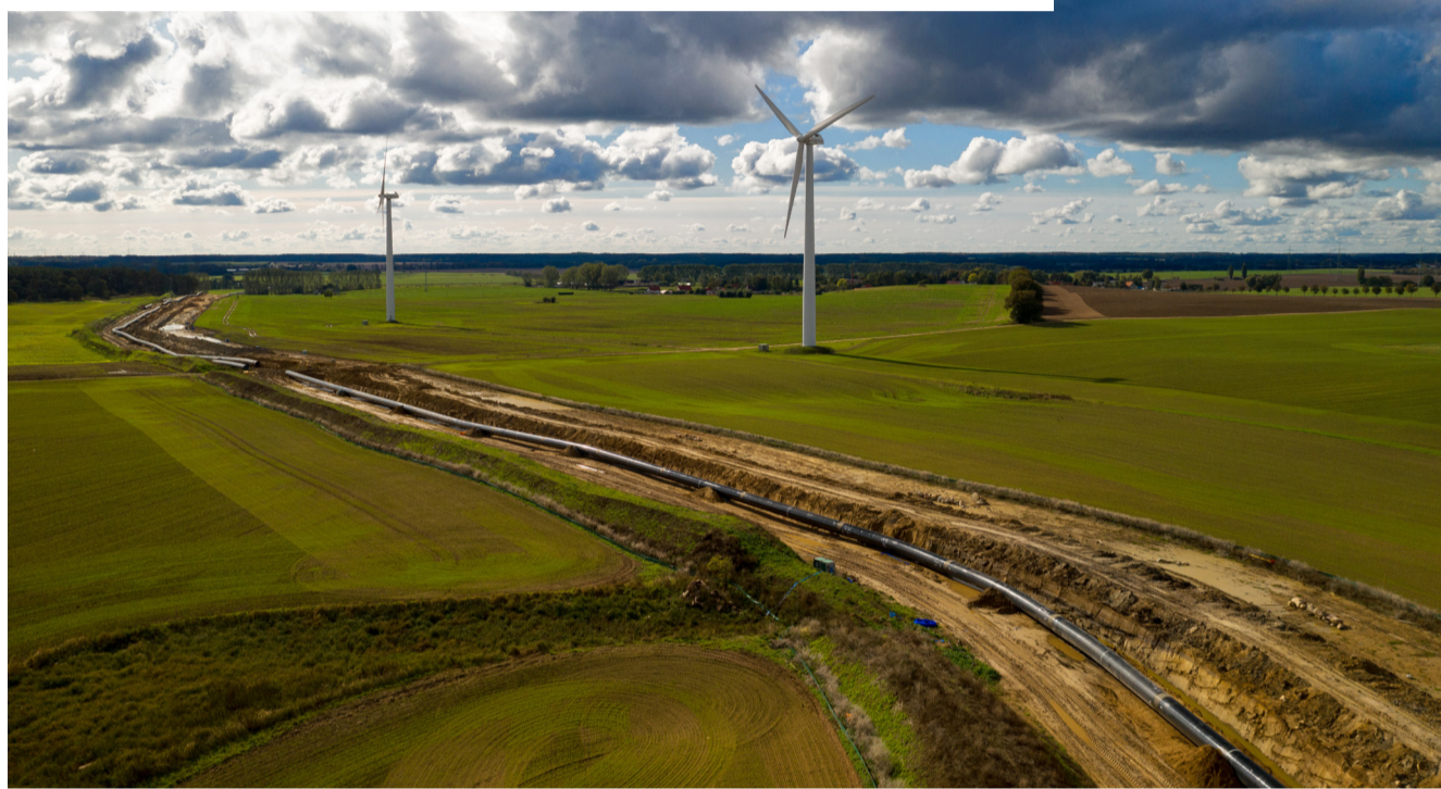
Construction du gazoduc reliant la Russie à l'Allemagne via la mer Baltique, achevée en septembre 2021.
